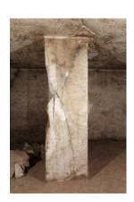
図 22 J室北壁、J室第 3柱、Je 室柱の亀裂
