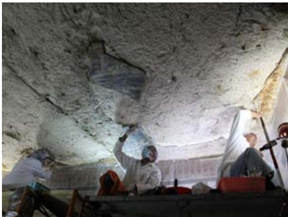
天井の修復の様子
