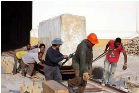
蓋石取り上げ作業
