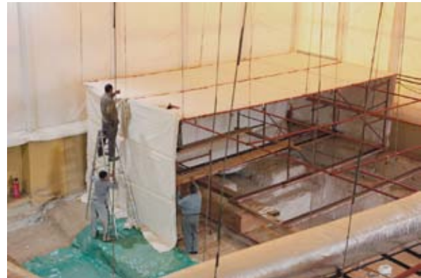
大テント内の設備建設
