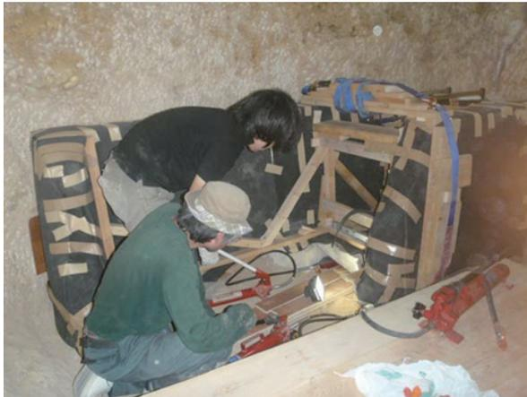
図6 油圧ジャッキを用いた石棺の移動
