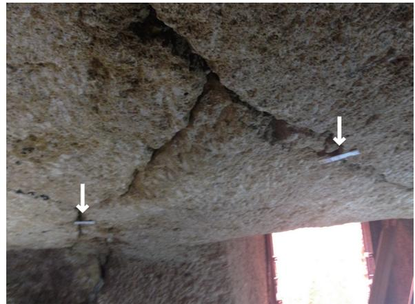
図12 2014年に天井に取り付けられた亀裂モニター
