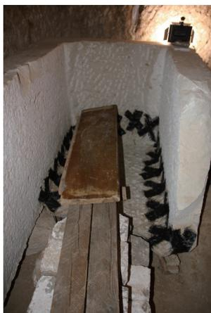
図4 カーボン・ファイバーによる亀裂の補強
